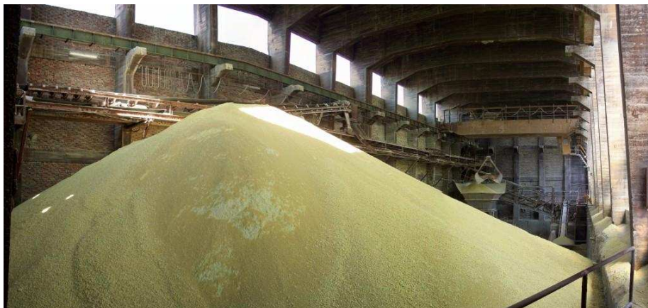
Vista del almacenamiento de azufre sólido.
